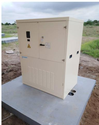
Fourniture et installation de 2 transfos élévateur et abaisseur de 6,5 KVA
