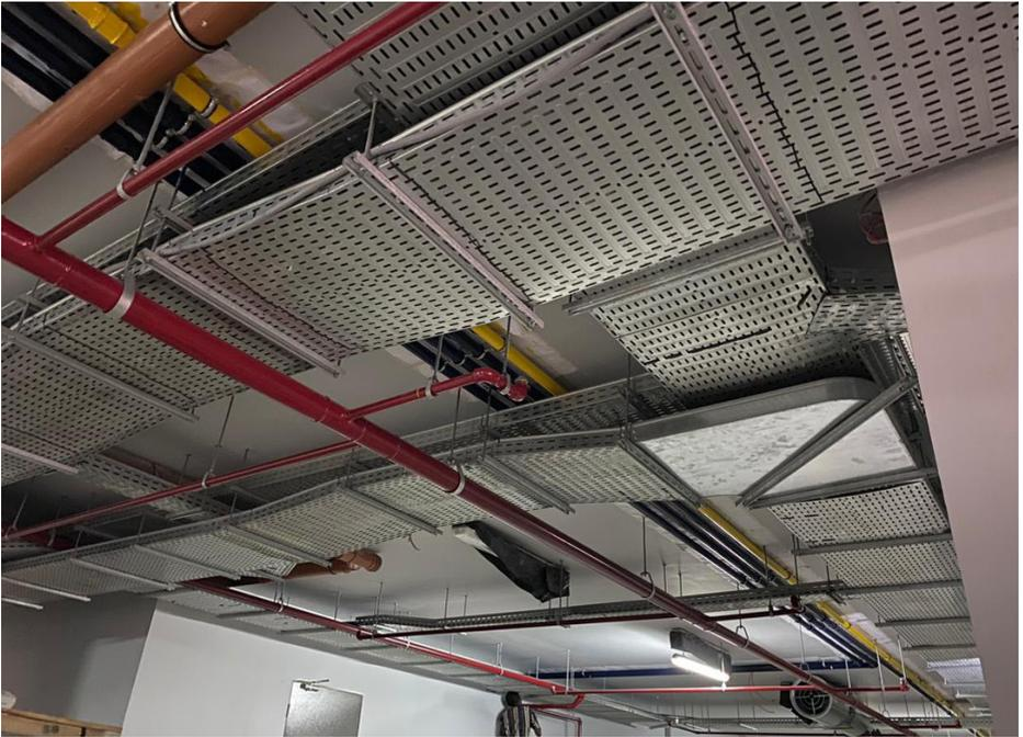
Fourniture et installation de dalles perforées pour un sous sol de 2000m<sup>2</sup>
