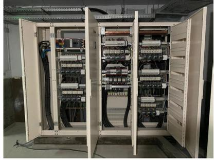
Fourniture et installation d'un TGBT et Inverseur automatique de 900 A
