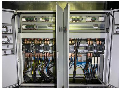
Fourniture et installation d'un tableau de synchronisation pour 3 groupes électrogènes de 500 KVA
