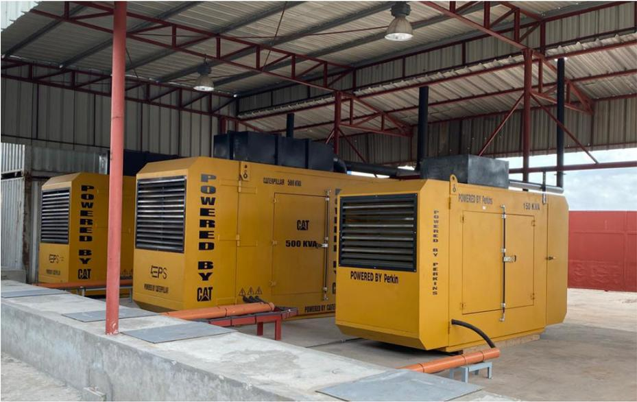
Fourniture et installation de groupes électrogènes de 1 150 KVA
