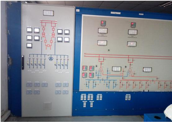
Fourniture et installation d'un tableau de commande à distance pour la cellule MCSET
