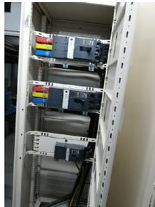
Fourniture et installation d'un ATS / inverseur automatique de 2 500 A
